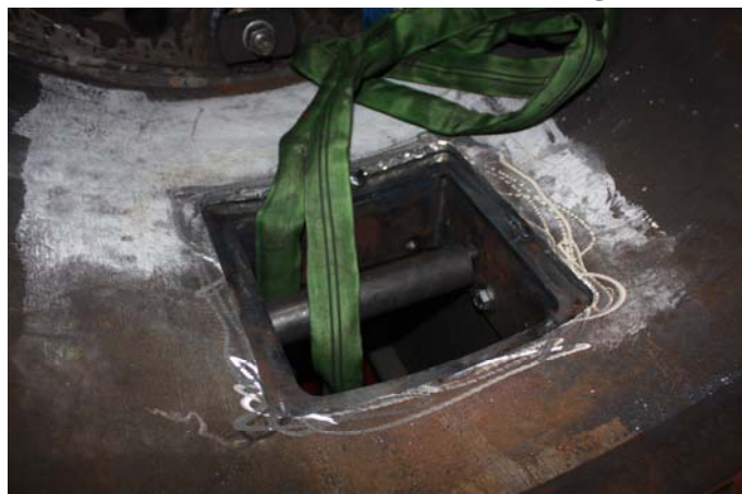
Der Löschefall wurde in den Rauchkammer- boden eingesetzt.
