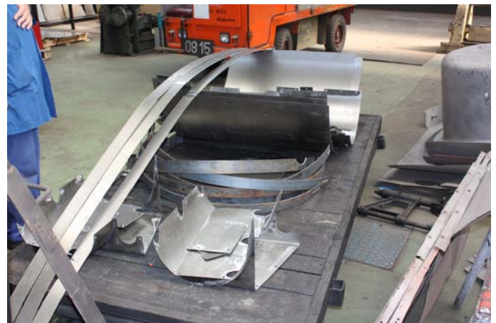
Bereitstellung der Verkleidungsbleche für Kessel, Zylinder und der Abdeckblechstreifen.
