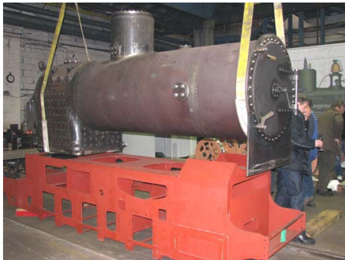
Die „Hochzeit“ von Kessel und Rahmen
