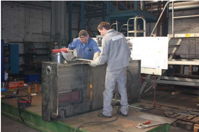
Fertigstellung der Arbeiten am rechten seitlichen Wasserkasten.
