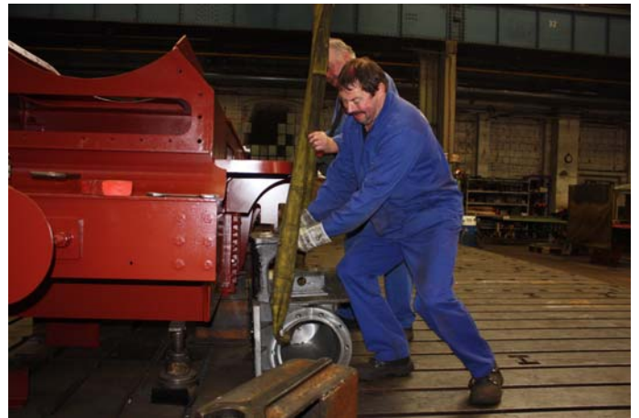
Montage des linken Dampfzylinders an den Lokomotivrahmen.
