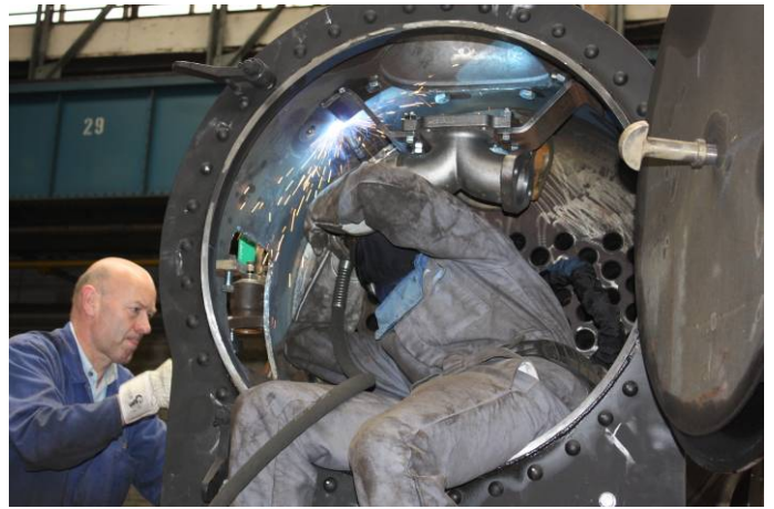
Die Träger des Ausströmzweigrohres werden an der Rauchkammerwand angeschweißt.
