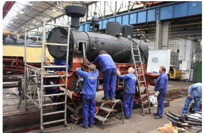
Anpassen des linken Einströmrohres zwischen Rauchkammer und Zylinder.
