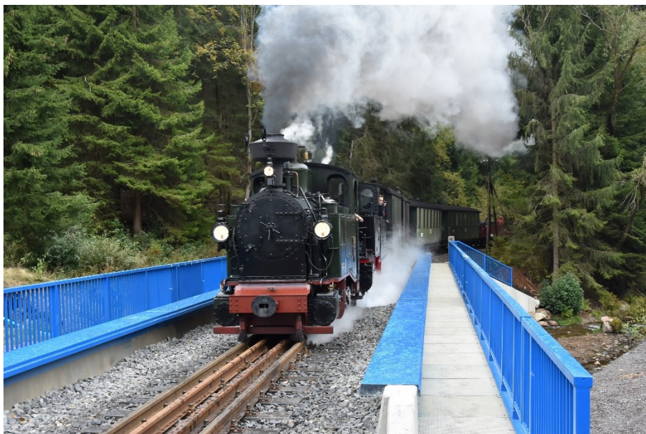
Bild 6: Befahrung der neuen Brücke am Bahnhof Schlössel durch die I K Nr. 54. (Foto: Thomas Poth)
