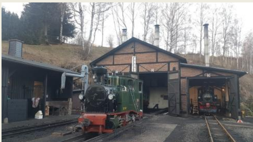
Bild 1: Vorbereitung auf den Start in den Frühling 2025 für die I K Nr. 54 vor dem Heizhaus in Jöhstadt am 12.03.2025. (Foto: Holger Drosdeck)
