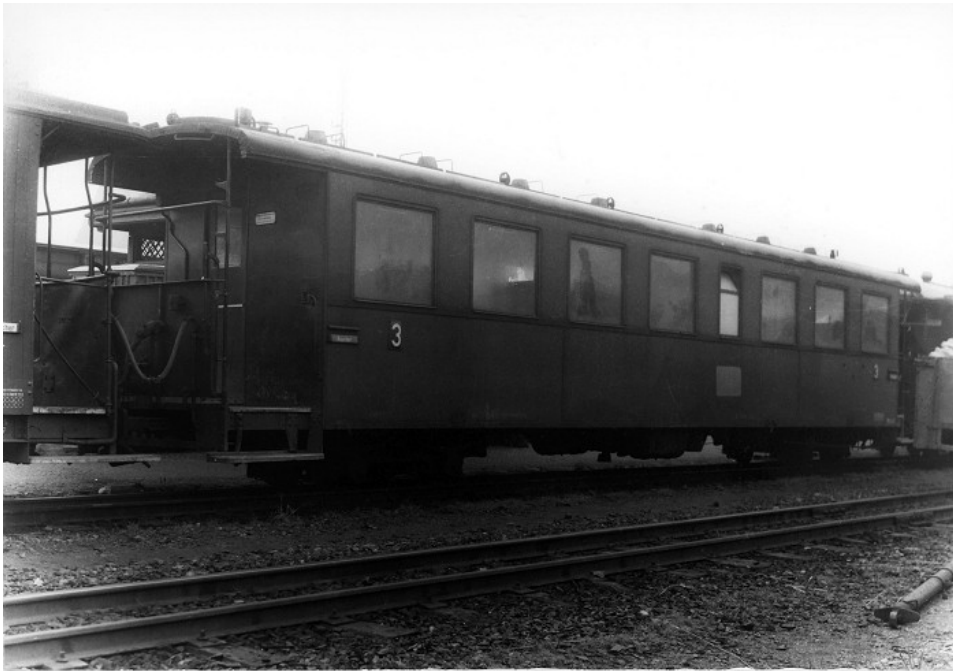
Bild 7: Der K 480 im Betriebseinsatz, hier in Freital-Potschappel 1946. (Foto: Sammlung André Marks)
